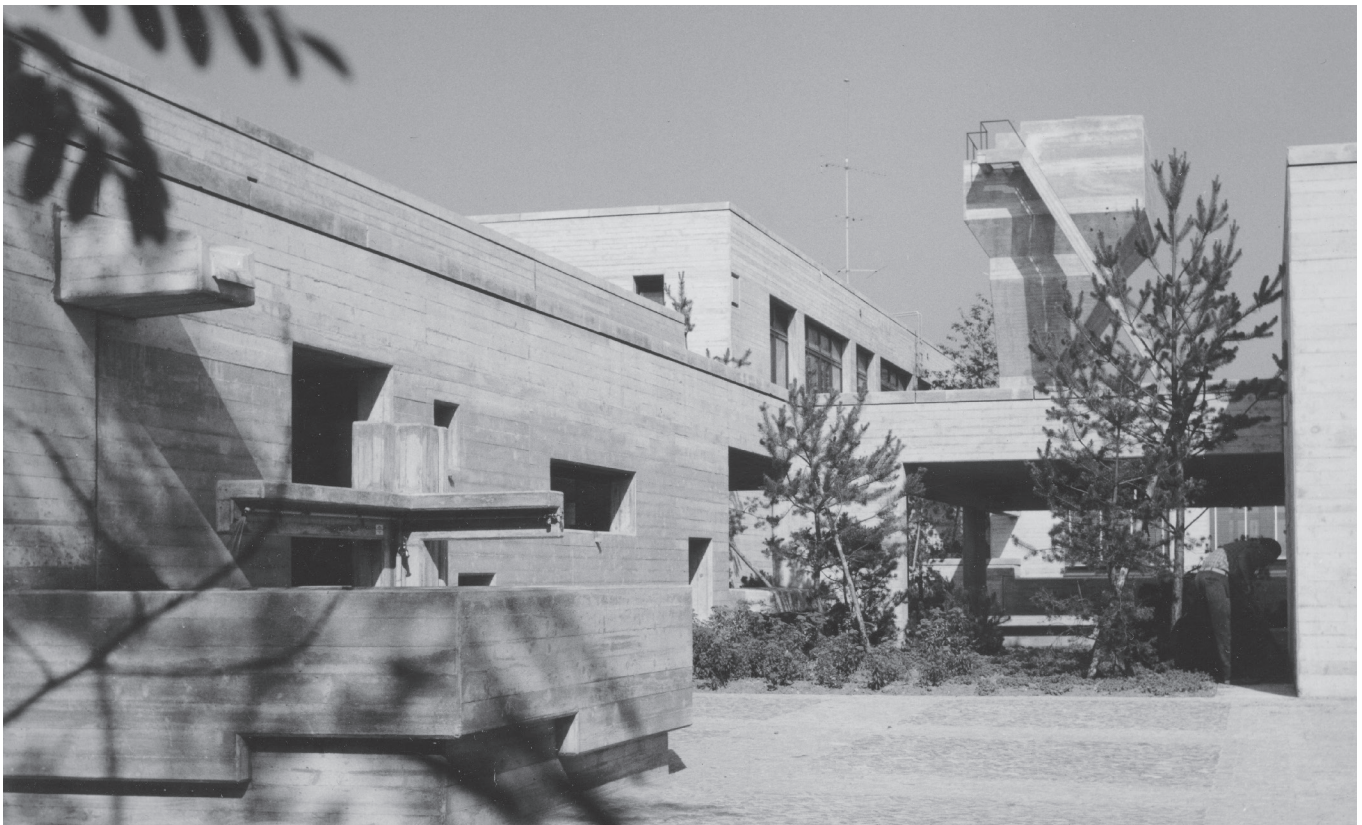
Werkjahrschulhaus (Foto: BAZ um 1965) Innenhof mit Holzspänesilo
